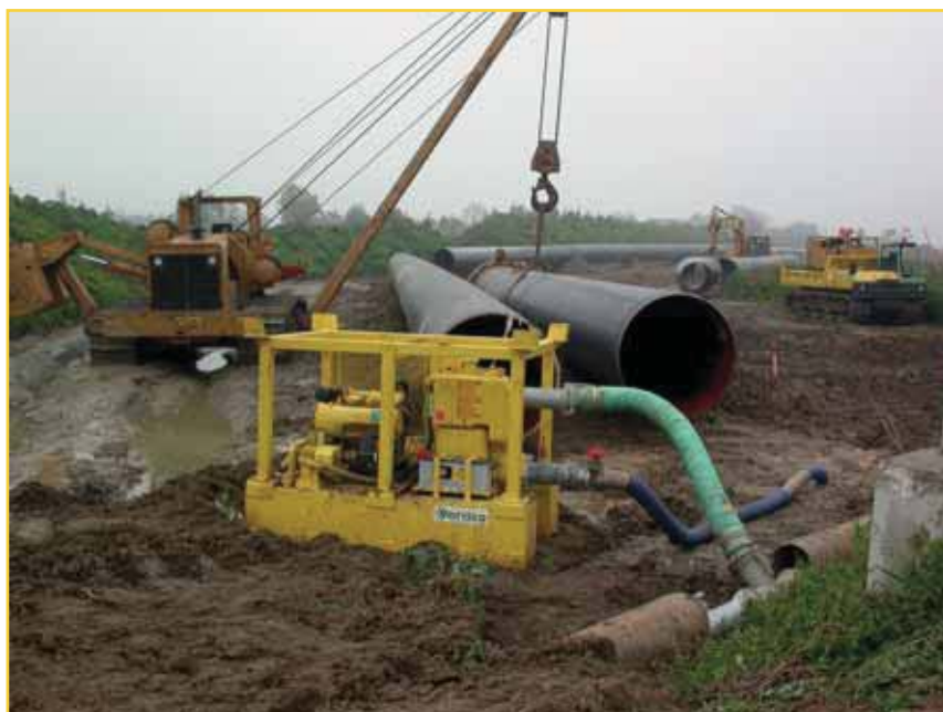
Drenaggio scavi per posa metanodotto Drainage excavation for pipeline installation Откачка воды из траншей для укладки газопровода
