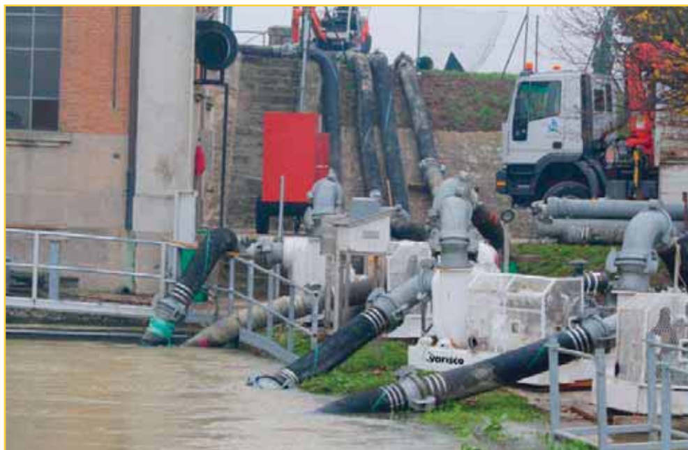
Drenaggio di zona allagata Drainage of flooded area Осушение затопленной местности
