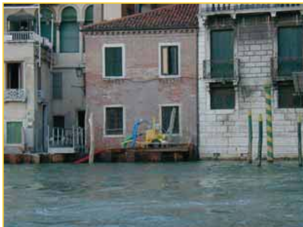
Lavori di conservazione a Venezia Restoration work at Venice Реставрационно-консервационные работы в Венеции
